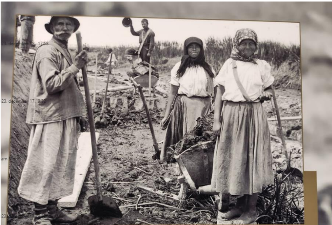
Kubikosmunka a Sió-csatornánál | 1910-es évek Work of navvies on the Sió Canal | 1910s
