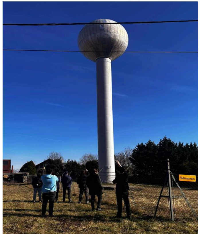
Víztorony 1. (Szijjártó E.)
